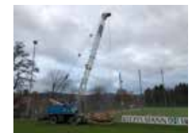
Die Brunnenbohrer am Werk
